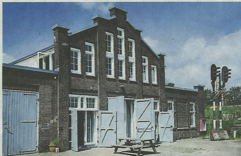
Op het dak van het Seinwezen komen in 2015 110 zonnepanelen. ARCHIEFFOTO
